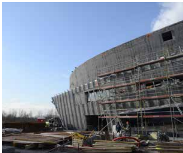
Construction du Centre de congrès à Mons sur le site « Ateliers SNCB » réhabilité par SPAQ/E
