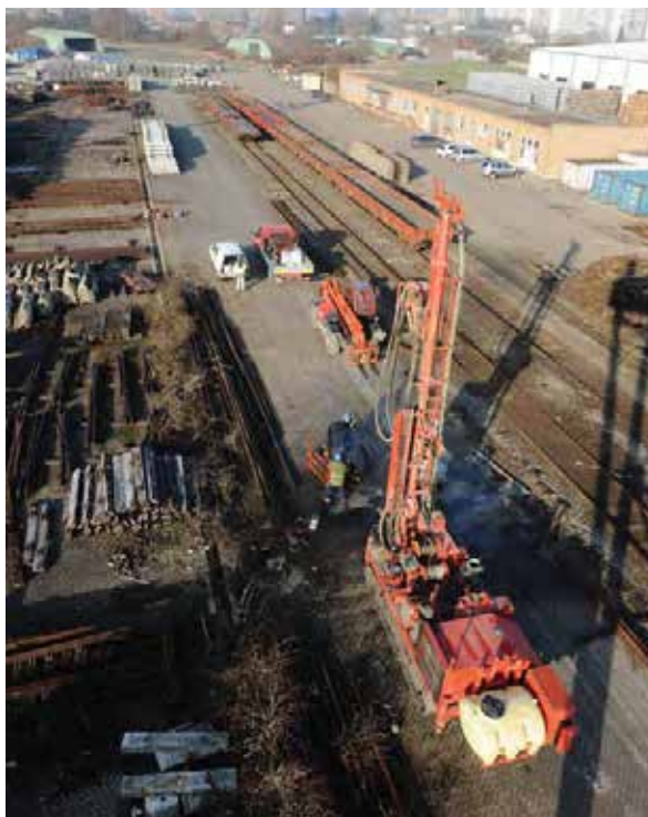
Prélèvements de sols sur le site « Cour aux marchandises SNCB » de Bressoux dans le cadre de l'implantation du futur tram liégeois
