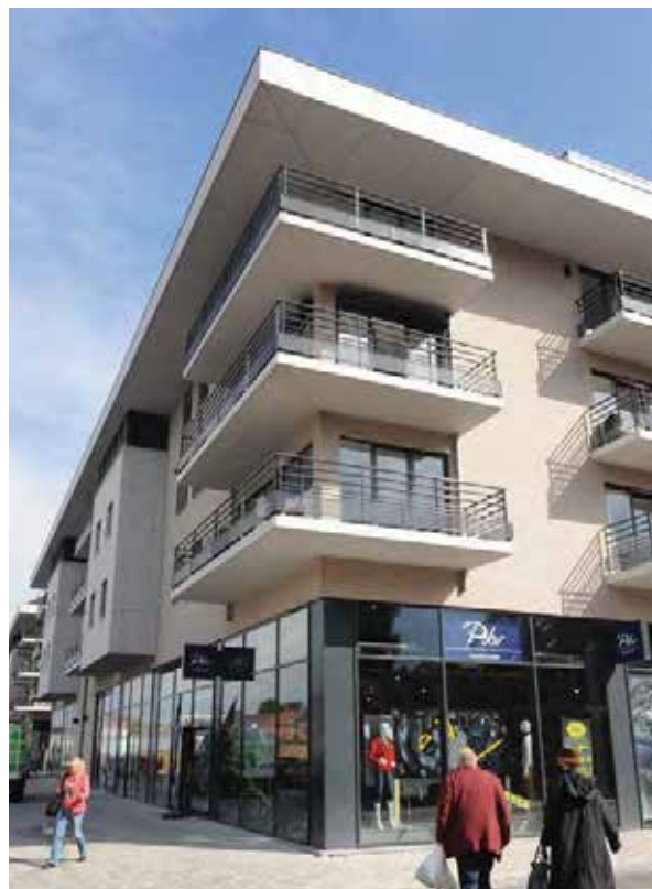
Complexe immobilier « Côté Senne » à Tubize
